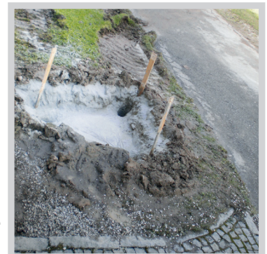
2. Verpresste Tiefenbohrung
