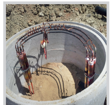
3. Schacht mit CO 2 -Tiefensonden
