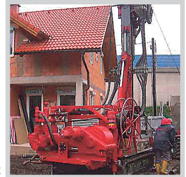
1. Bohrung mit Bohrergerät
